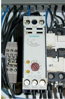
Рисунок 1 -Електромагнітне реле часу
