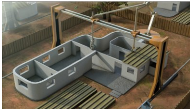
Рисунок 1 – Принцип 3D-друку будинку
