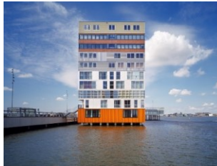
Рисунок 1 – Житловий комплекс Silodam / Амстердам
